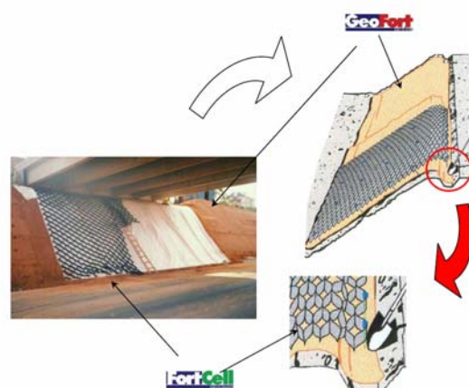
Figura 4 – Instalação da geocélula FORTCELL.
