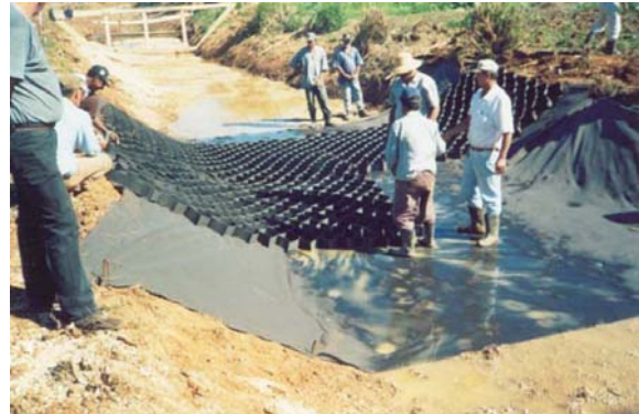
Figura 3 – União das seções de FORTCELL.
