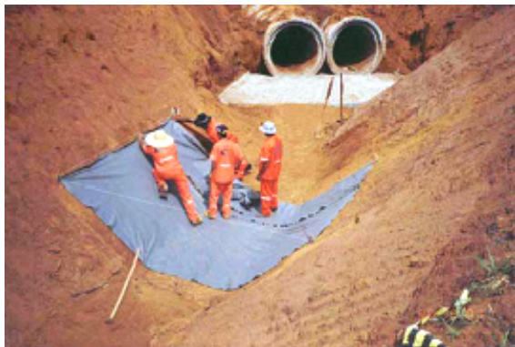
Figura 2 – Instalação do GEOFORT.
