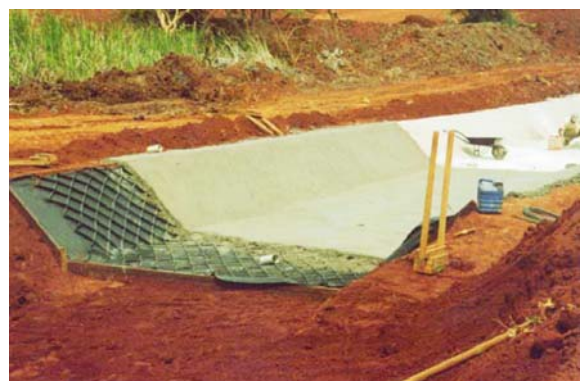
Figura 5 – Canal revestido com FORTCELL.
