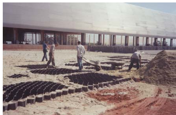
Figura 3 – Disposição e preenchimento das peças de FORTCELL.
