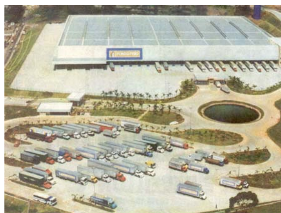
Figura 4 – Vista aérea do pátio de um estacionamento após a instalação do FORTCELL.
