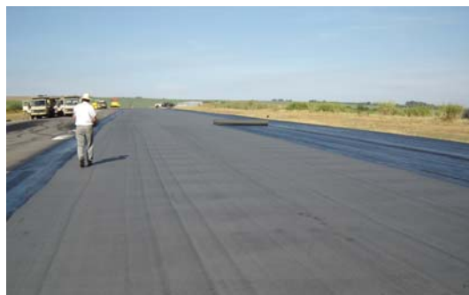
Figura 01 – Geotêxtil instalado sobre o pavimento danificado.
