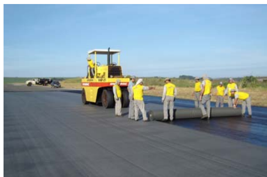
Figura 03 – Instalação do geotêxtil manualmente.
