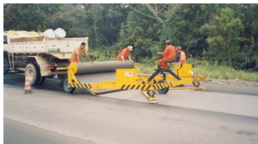
Figura 02 – Instalação do geotêxtil mecanicamente.
